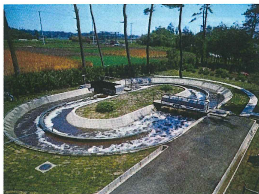
写真 昭和44年に神奈川県畜産試験場に建設された家畜用浄化槽
